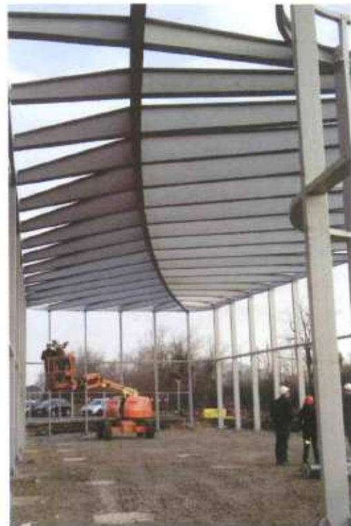
CHARPENTE RÉALISÉE PAR L'ENTREPRISE BLANCHET POUR LES ATELIERS DE WEISS EN CONSTRUCTION
